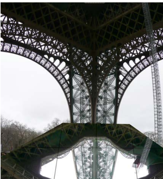
Détail du miroir : vue plongeante de la structure métallique de la Tour Eiffel.
